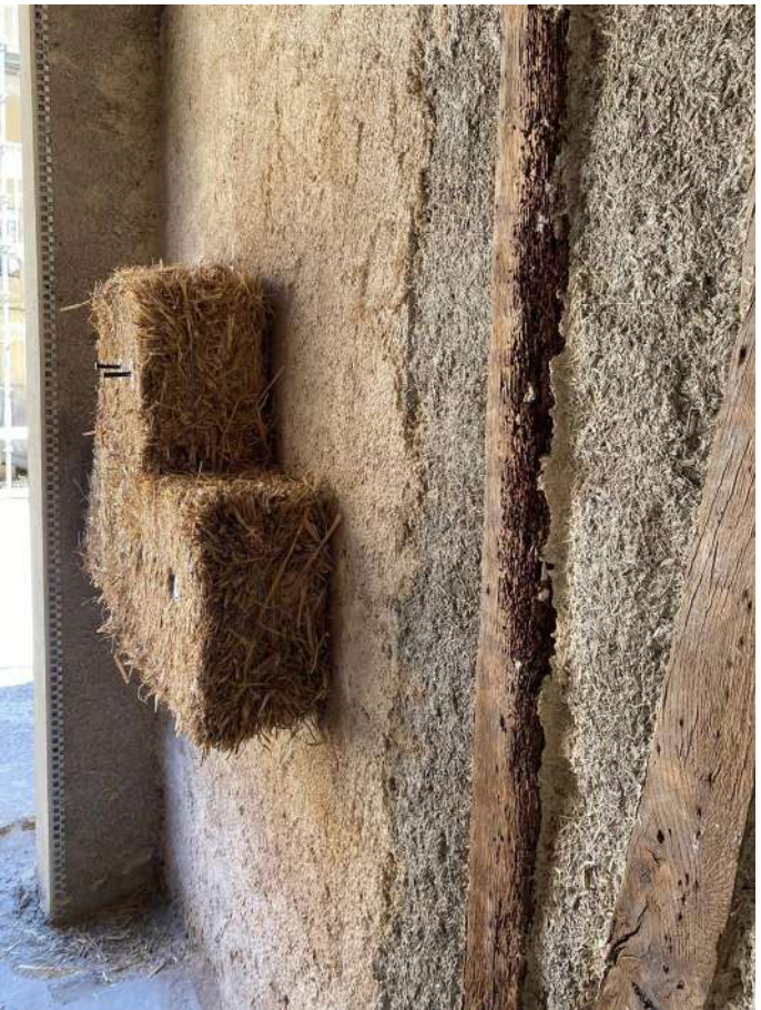
Journée chantier paille
