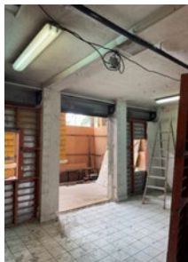
Photos chantier RDC
