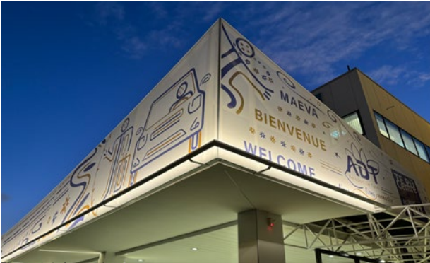
Photos de la façade de l'aéroport
