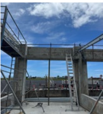
Photos du chantier
