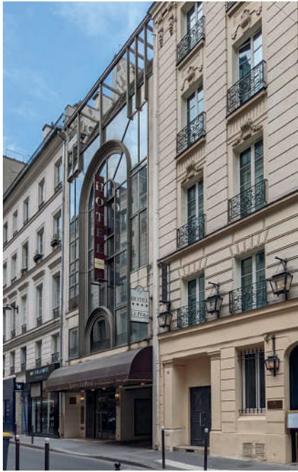
Photographie de la façade existante
