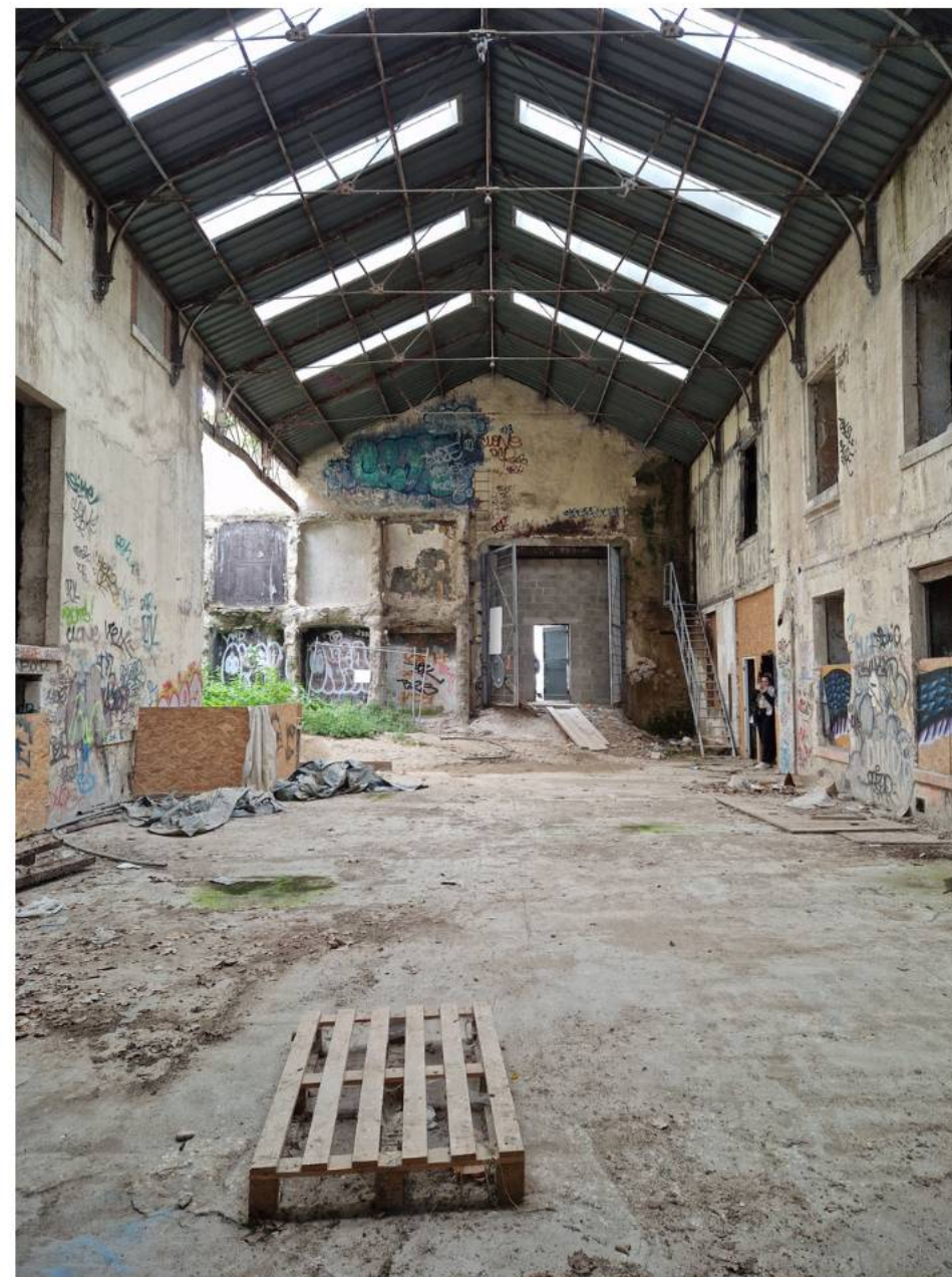
Espace de restauration - existant
