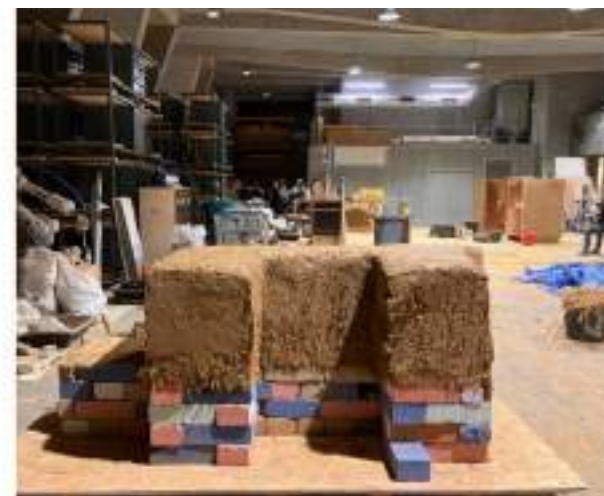
Fin de la construction du mur en bauge et nettoyage de l'espace de travail
