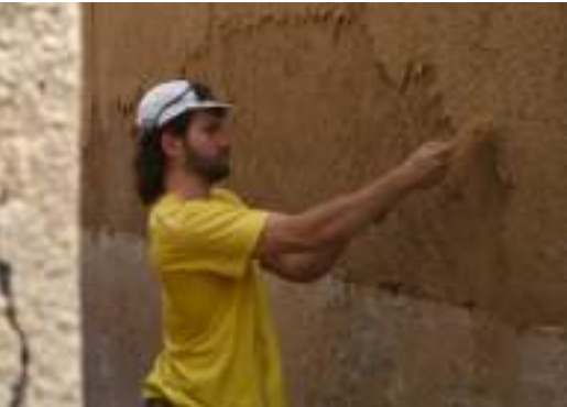
Dépose de l'enduit existant
