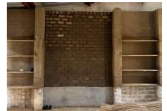
Mise en oeuvre
