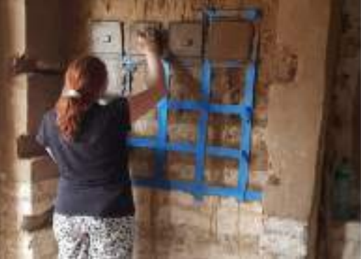
Mise en place des matrice
