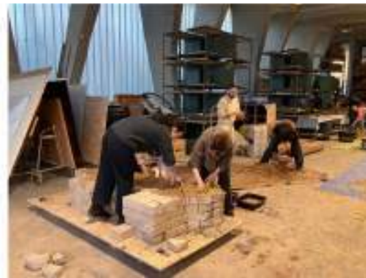
Pose d'une fine couche de barbotine sur le sous-bassement
