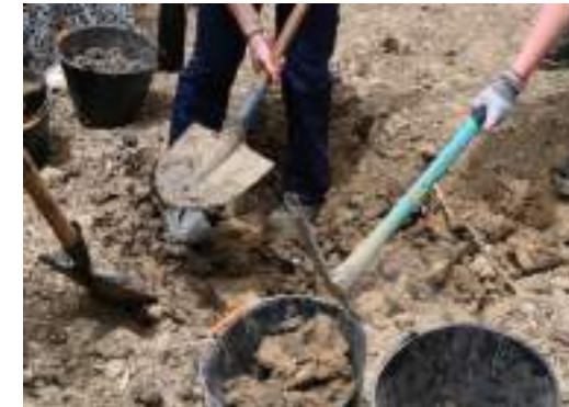
Extraction de la terre à 20km du chantier
