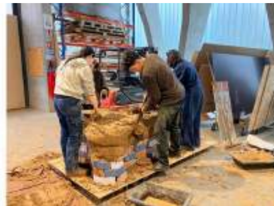
Fin de la pose de la première levée et découpe de l'excédent
