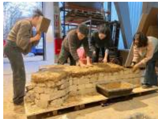
Début de la réalisation du mur en bauge
