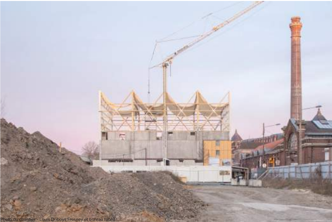
Photo du chantier - Louis Dubois Fresney et bureau faceB
