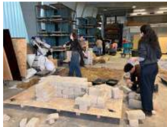
Réalisation du sous-bassement en BTC
