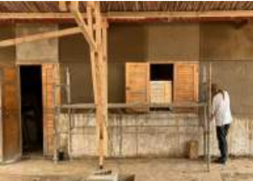
Pose du nouvel enduit de terre
