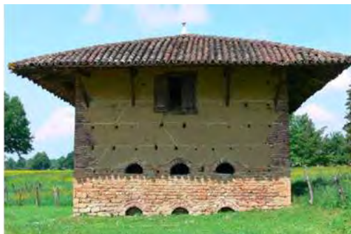
Fig 2 : Exemple d'une maison en terre crue avec un toit imposant et un sous-bassement en pierre. Photo: CRATerre - ENSAG
