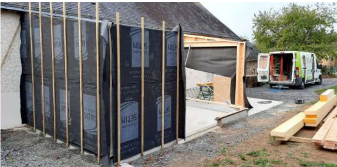
Stage ouvrier 2020 - Agrandissement ossature bois
