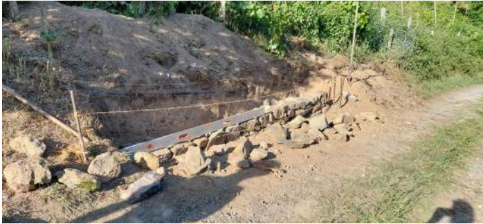
Chantier 2025 - Construction d'un muret en pierre sèche
