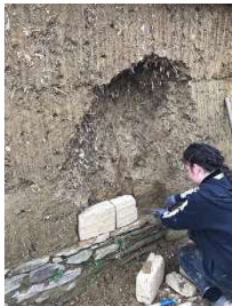
Chantier 2025 La Grande Frinière - Réparation de bauge
