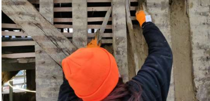
Chantier 2025 La Grande Frinière - Torchis
