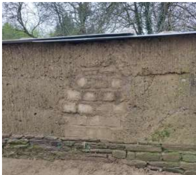
Chantier 2025 La Grande Frinière - Réparation de bauge
