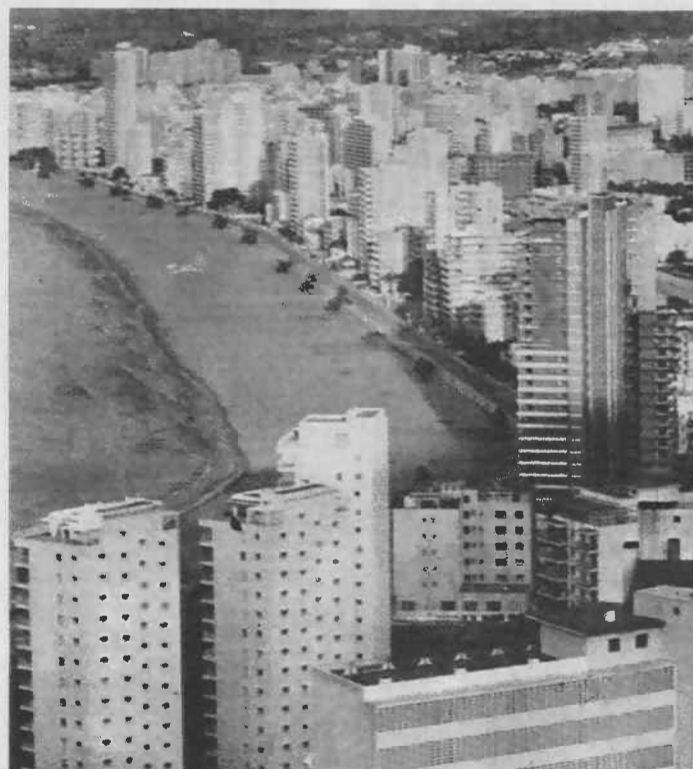
Las huelgas de los trabajadores de hostelería han puesto al descubierto la otra cara de la temporada turística.
