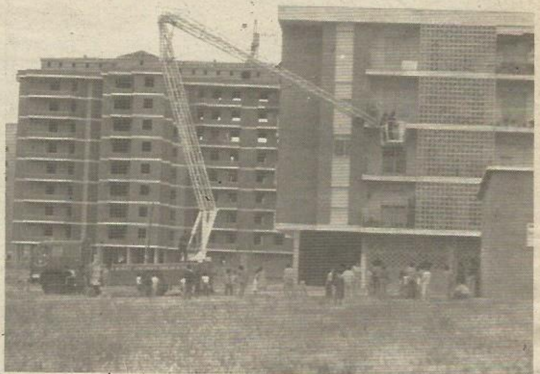
Para nadie es un secreto que determinadas constructoras son mafiosas. En la foto, los bomberos inspeccionando uno de los pisos afectados de Torrejón.
