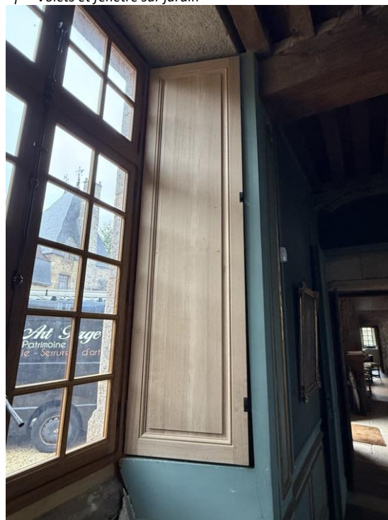
Intégration dans les boiseries
