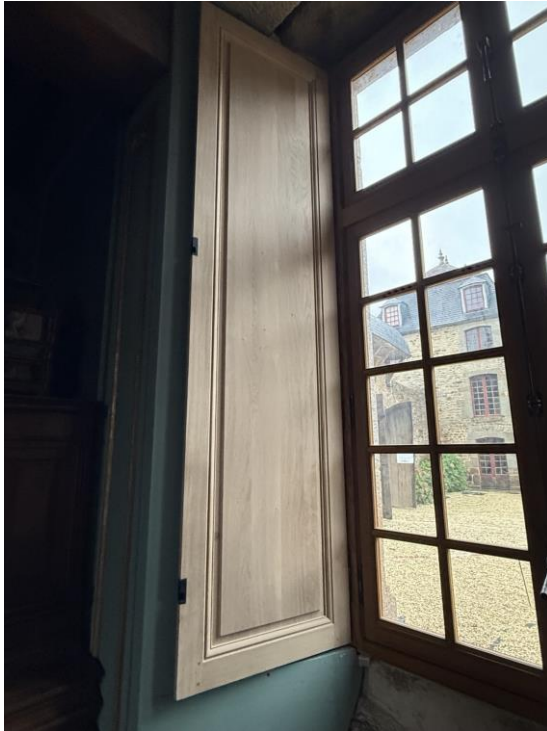
Volet en place dans l'ébrasement / Volet peint de l'étage
