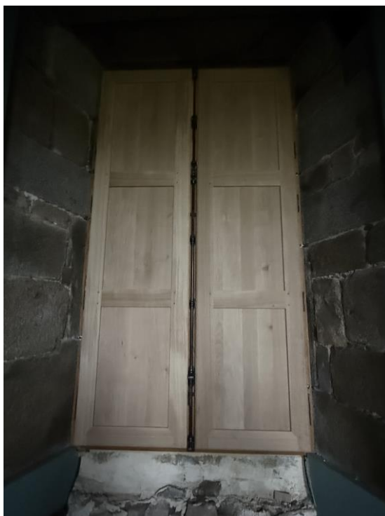
Volets du salon, vue en feuillure
