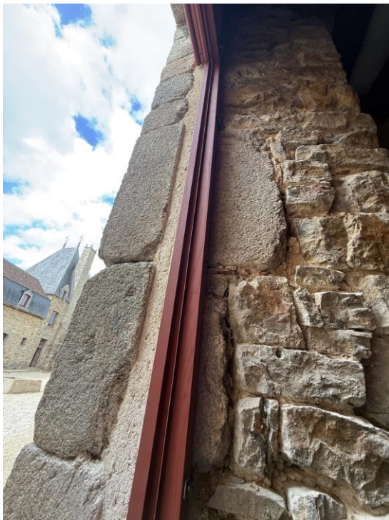
Vide périphérique restant à calfeutrer et prolonger le nu des pierres en mortier avec une patine
