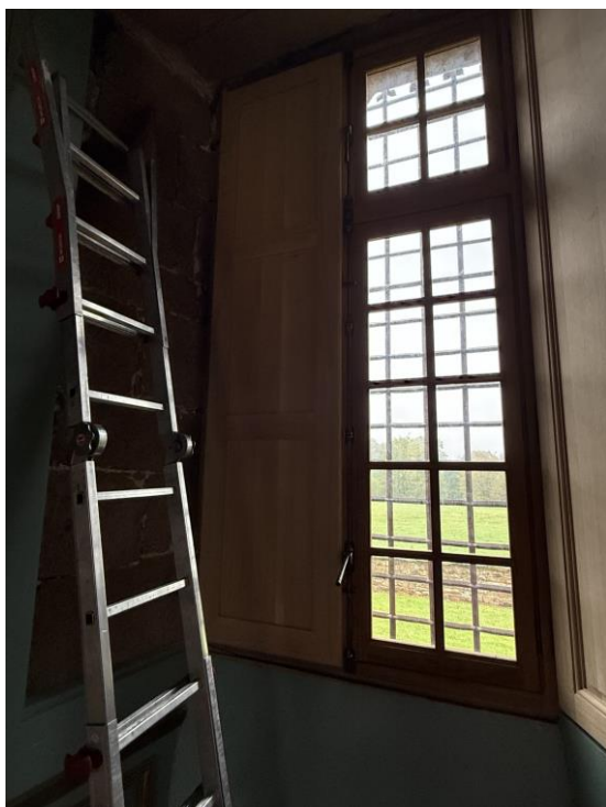
Volet tour Sud-ouest
