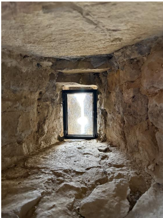
Vue d'un châssis sur glacié très prononcé avant son rehaussement.
