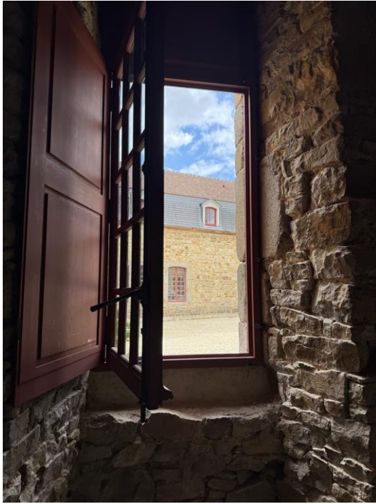
Menuiserie palier étage posée - vue intérieure de l'embrasure.
