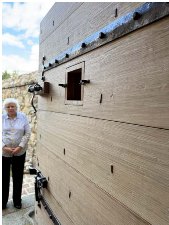
Judas - cadre intérieur et loquets à pivot.
