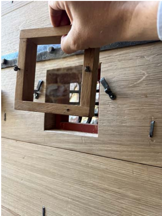
Judas - cadre vitré déposé pour accès à la grille.
