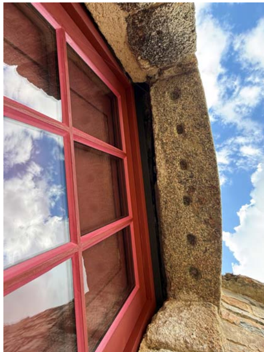
Détail extérieur avant calfeutrement définitif.
