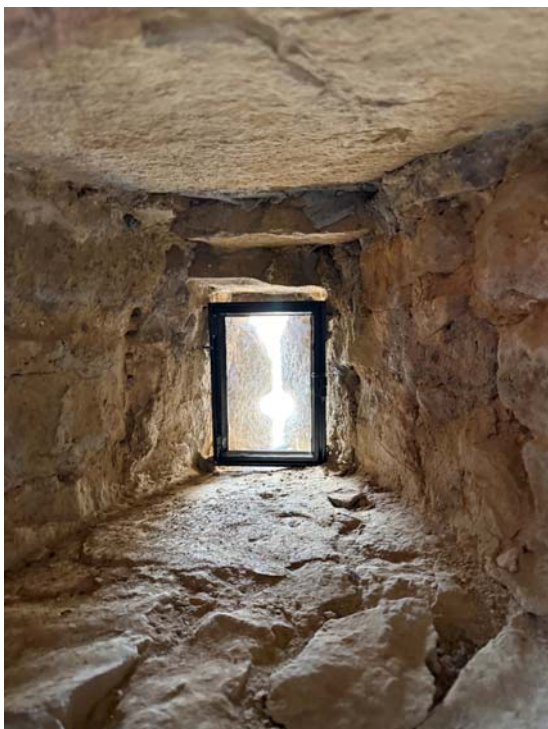
Vue d'un châssis avec glacié très prononcé.
