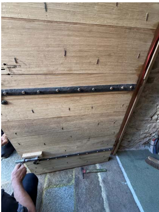
Vue d'ensemble du revers de la porte et des ferrures.
