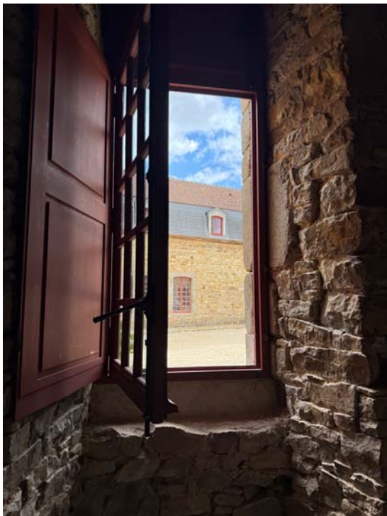
Menuiserie définitive posée - vue intérieure de l'embrasure.
