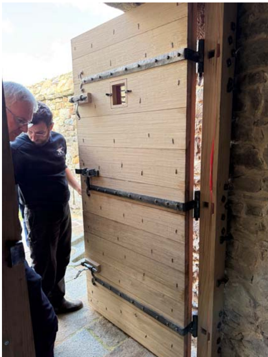
Porte nord - vue intérieure générale après réglages.
