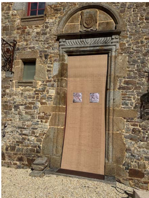
Gabarit à l'échelle 1 de la porte principale dans la baie existante.
