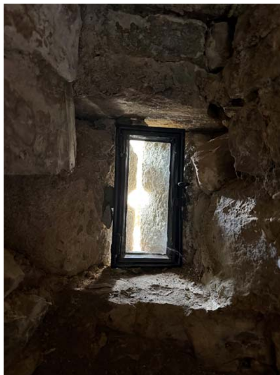
Détail d'un châssis métallique de meurtrière.
