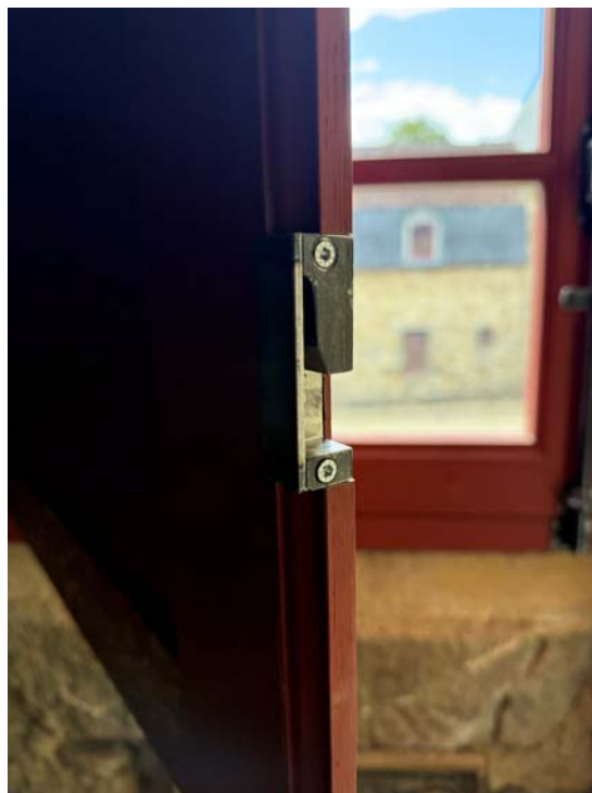
Détail de quincaillerie d'un châssis métallique.
