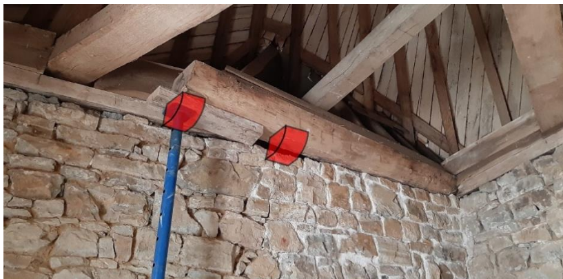
Vue sur la sablière dans les combles de la tour ronde avec les corbeaux en pierre projetés.
