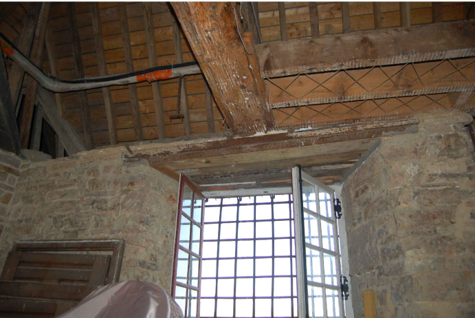
Vue sur l'état existant avec l'entrait de la ferme reposant sur le linteau de la baie.
