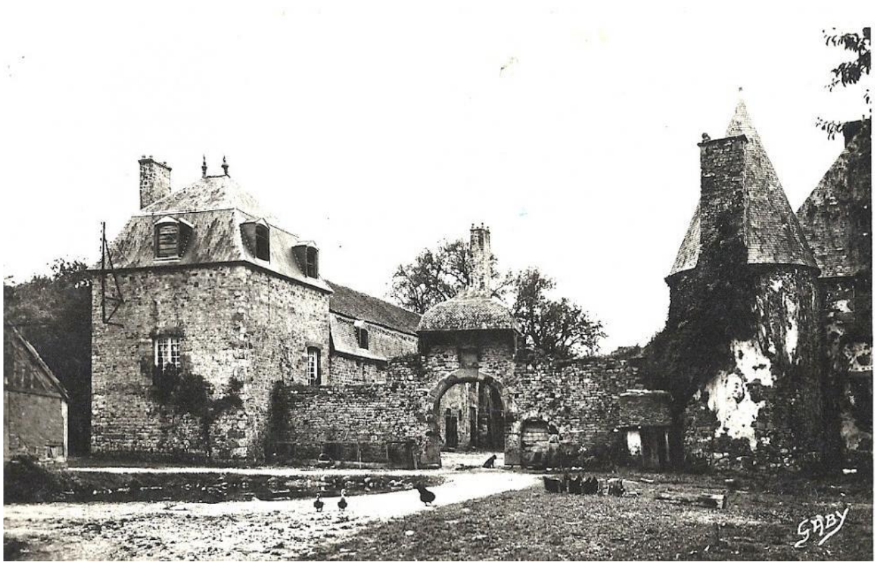
Vue sur le manoir depuis l'entrée du site, années 1930
