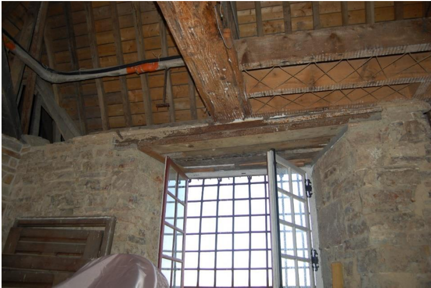
Vue côté est, sur la baie du dernier étage donnant sur le jardin. On peut constater que l'entrait de ferme repose directement sur l'arrière-linteau.
