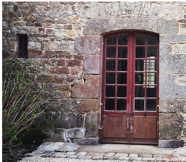
Vue sur la fenestrelle FE01.
