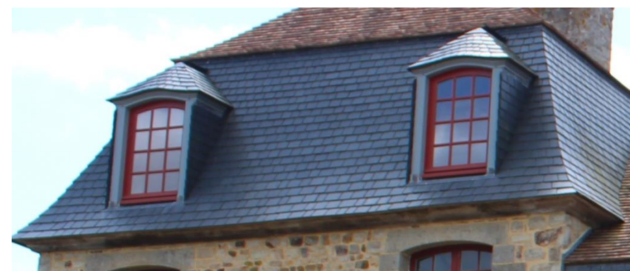
Vue sur les lucarnes LE31 et LE32.
