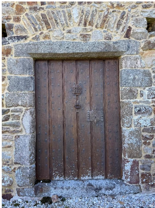
Vue sur la porte nord de la chapelle – EXISTANT.
