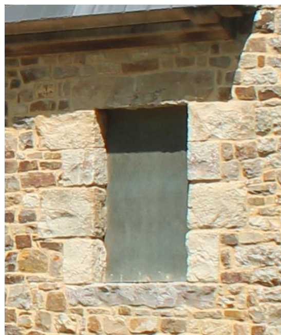
Vue sur la baie FO12 - EXISTANT
