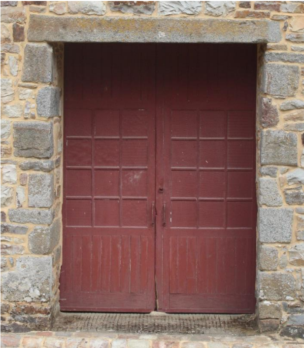
Vue sur la porte PO01 – EXISTANT.
