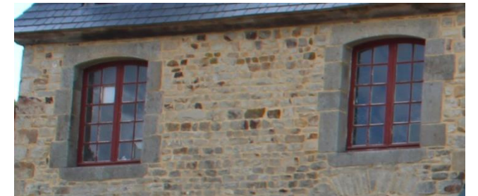
Vue sur les menuiseries FE21 et FE22.
