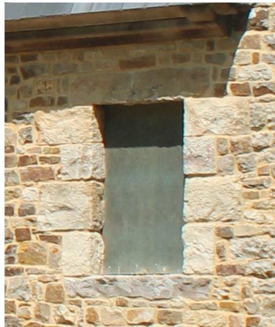
Vue sur la baie FO12 - EXISTANT
