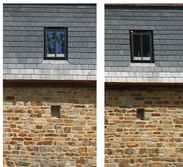
Vue sur les fenestrelles FeO11 et FeO12.
