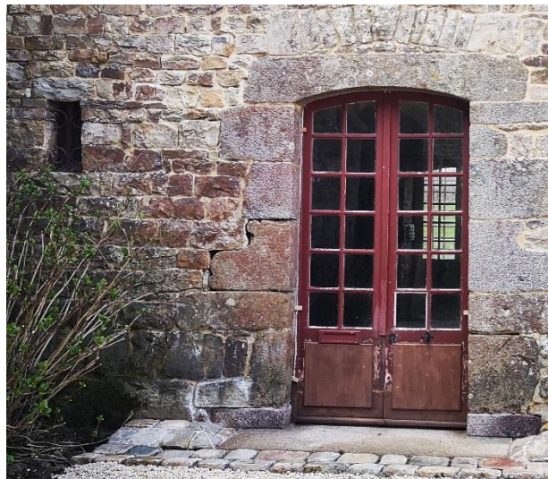
Vue sur la fenestrelle FE01.
