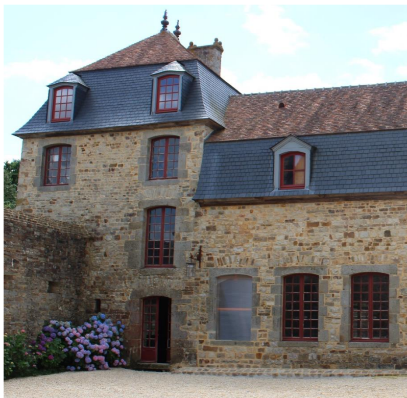
Vue sur les menuiseries FE11, FE03, FE04 et FE02.
