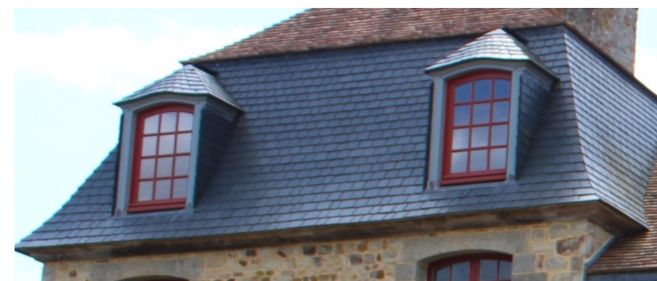
Vue sur les lucarnes LE31 et LE32.
