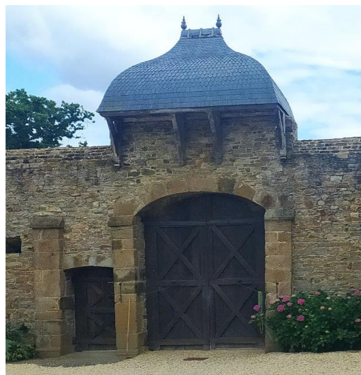
Vue sur le portail d'entrée, face côté cour – EXISTANT.
