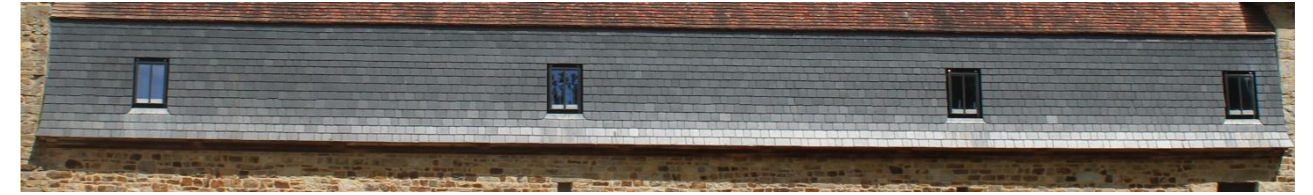
Vue sur les châssis actuels de la façade ouest des écuries.
