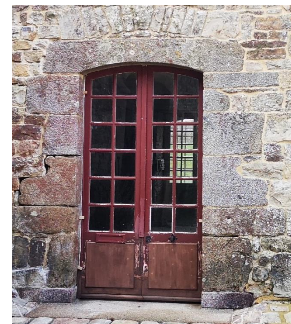
Vue sur la menuiserie PE01.
