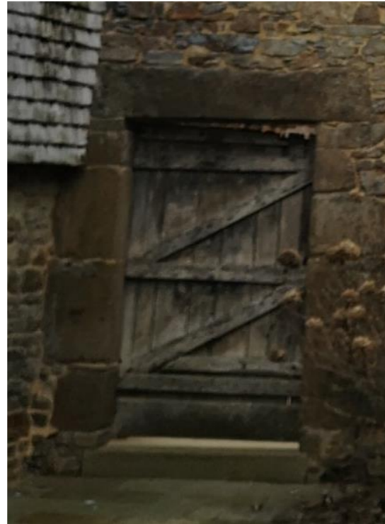
Vue sur la porte nord de la cour, face jardin – EXISTANT.
