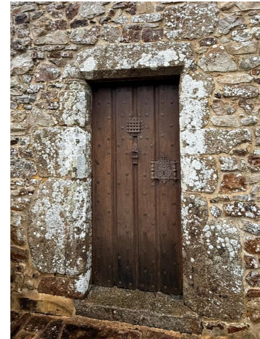
Vue sur la porte ouest de la chapelle – EXISTANT.
