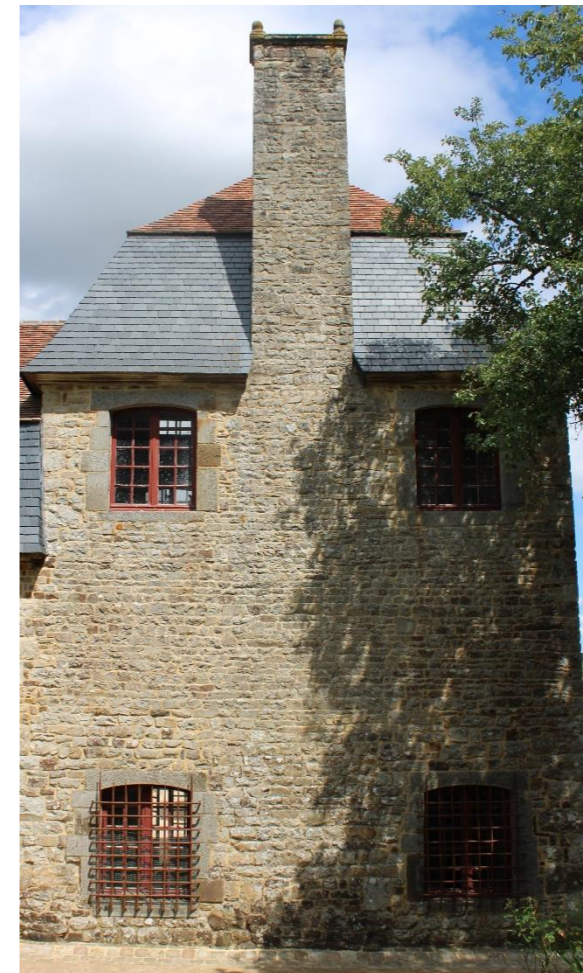
Vue sur les menuiseries FO21, FO22, FO03 et FO04.
