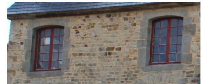
Vue sur les menuiseries FE21 et FE22.
