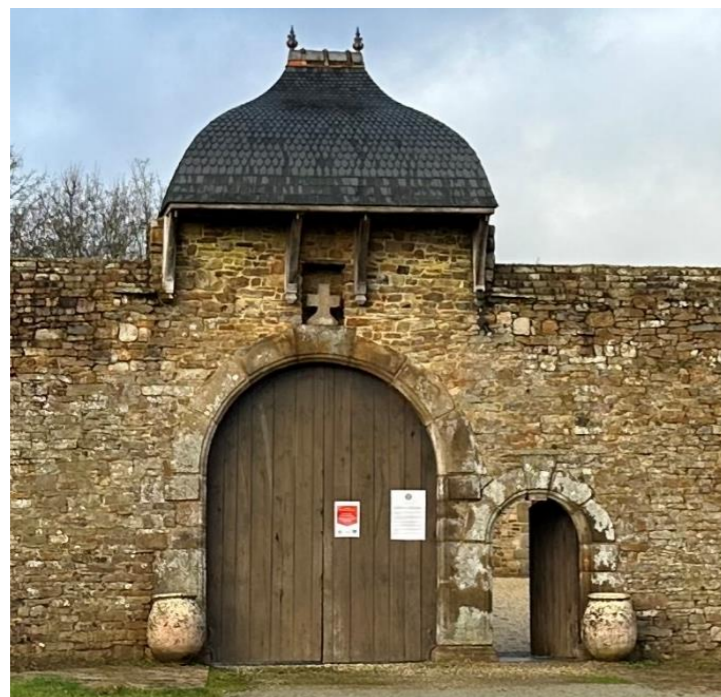
Vue sur le portail d'entrée, face extérieure – EXISTANT.
