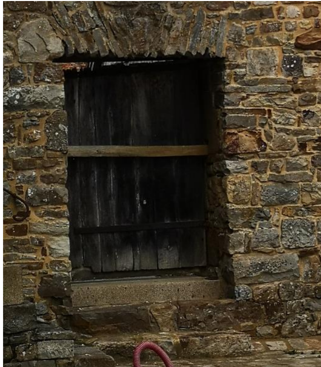
Vue sur la porte nord de la cour, face cour – EXISTANT.
