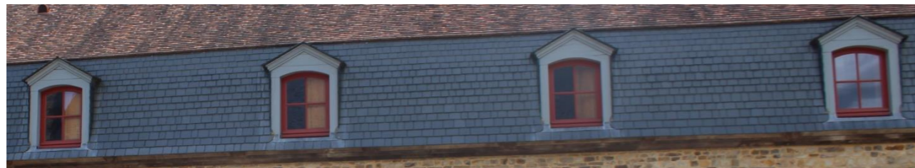
Vue sur les lucarnes LE21, LE22, LE23 et LE24 - EXISTANT.
