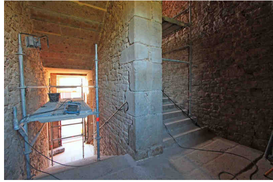
L'ESCALIER DU REZ-DE-CHAUSSÉE QUI MÈNE AU PREMIER ÉTAGE
