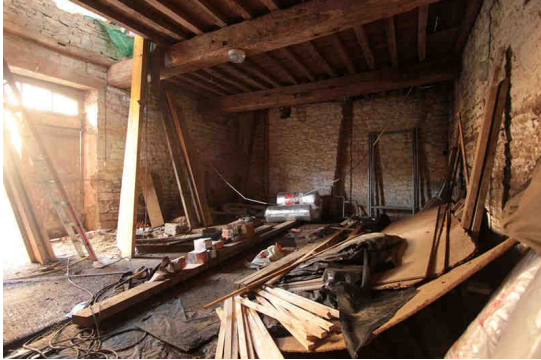
LE REZ-DE-CHAUSSÉE DES ÉCURIES
