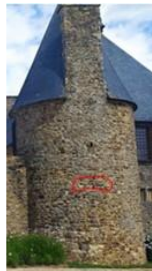
Souche de cheminée de la tour sud-ouest. On remarque l'arc de décharge de la fenêtre d'origine rebouchée.
