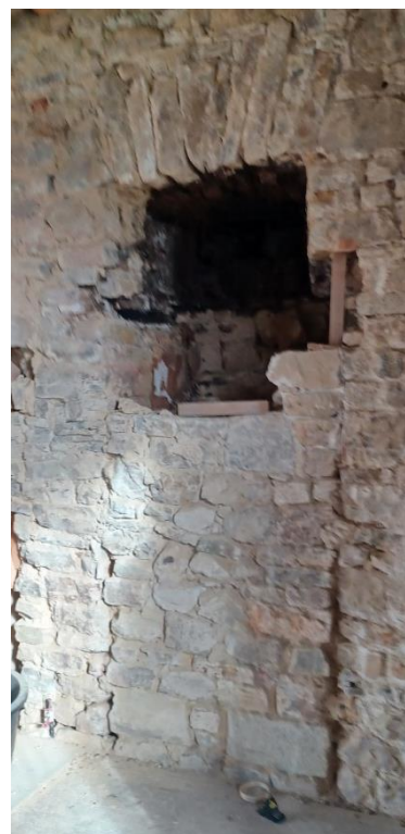
Photo, depuis l'intérieur, des vestiges d'anciennes ouvertures.
