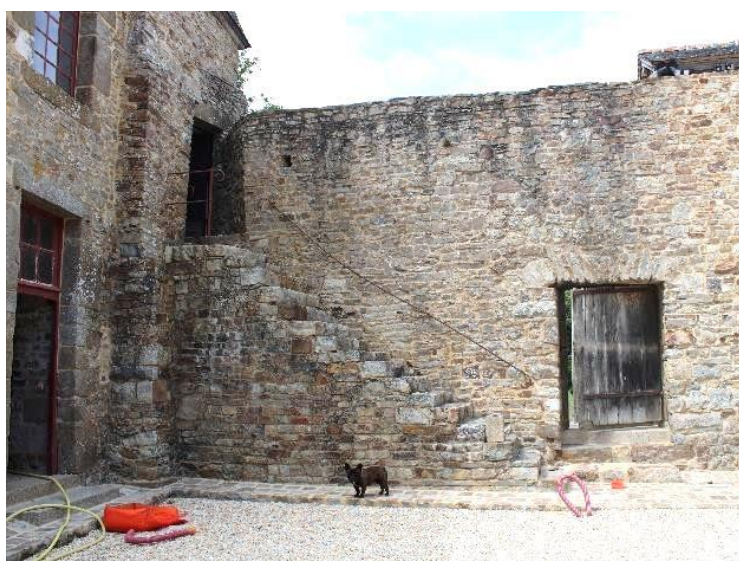
Escalier extérieur du pavillon Louis XIII restauré.
