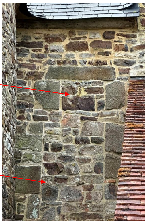
Photo, depuis l'extérieur, des vestiges d'anciennes ouvertures.
