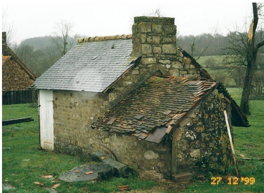
Fournil de la ferme avant sa restauration.
