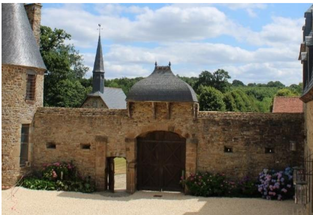
Mur d'entrée sud depuis la cour.
