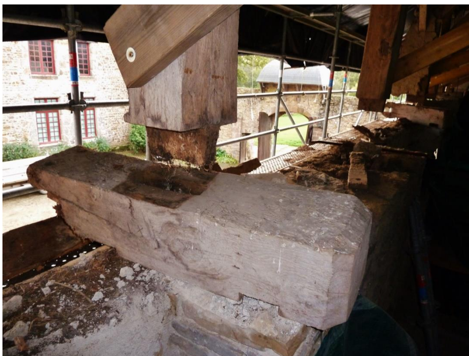
La charpente des écuries soulevée d'un bloc pour permettre sa restauration.
