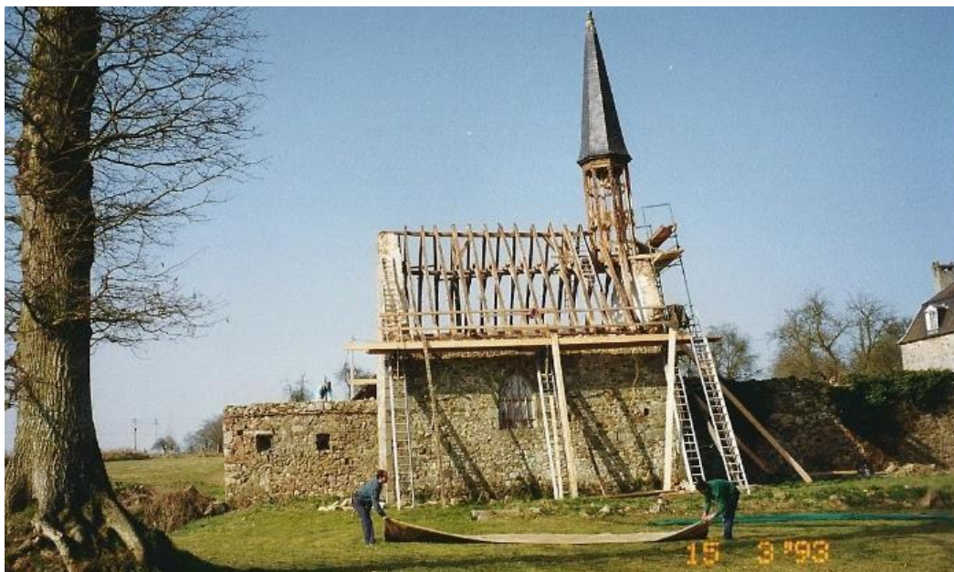
Restauration de la charpente de la chapelle en 1993.
