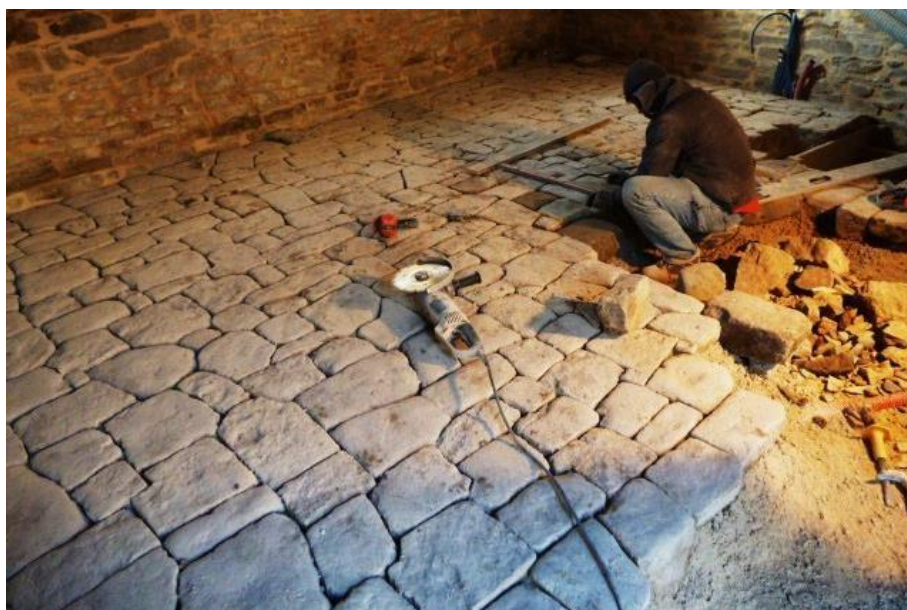
Pose du dallage de récupération au rez-de-chaussée du pavillon Louis XIII.
