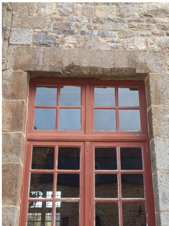
Le linteau d'une fenêtre du logis avant sa restauration.
