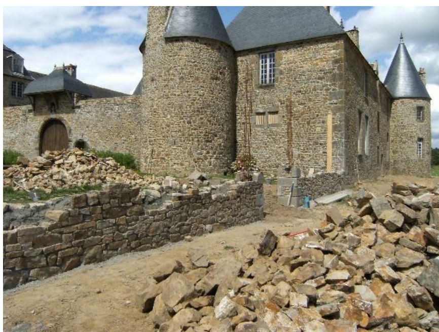
Le mur de banc de tir sud en cours de restauration.
