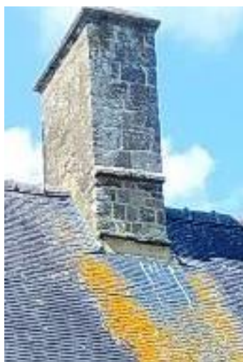
Souche centrale du logis. Le jet d'eau montre de combien fut abaissée la toiture à la suite de l'incendie de 1884.
