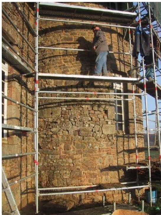
Tour nord-est en cours de rejointoiement.
