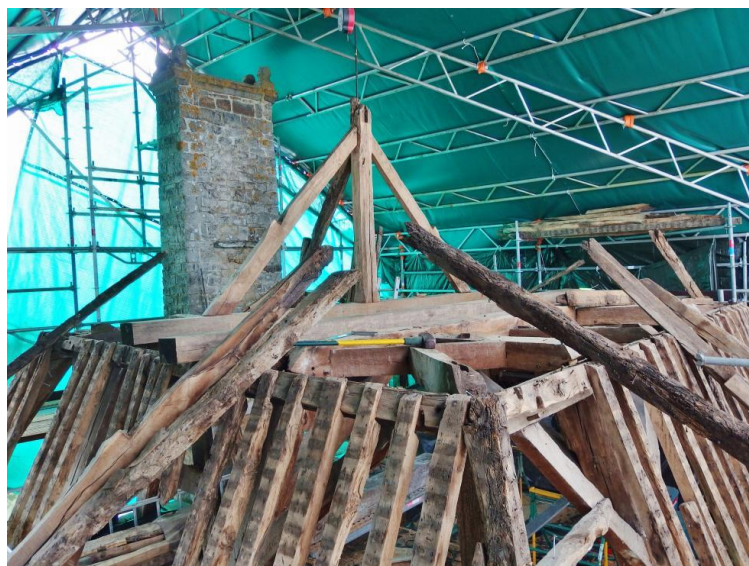
La charpente du colombier en cours de restauration.
