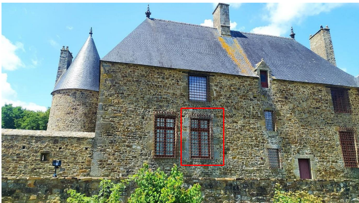
Façade sur douve du logis. On remarque la différence dans l'appareillage de l'entourage de baie de la fenêtre percée lors de la partition de la plus grande pièce du rez-de-chaussée.
