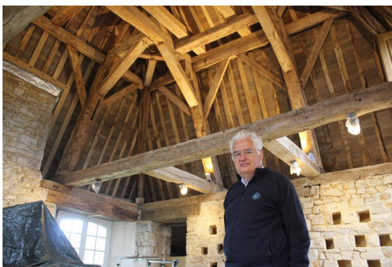
Vue sur les combles du colombier et sur les boulins après leur restauration.
