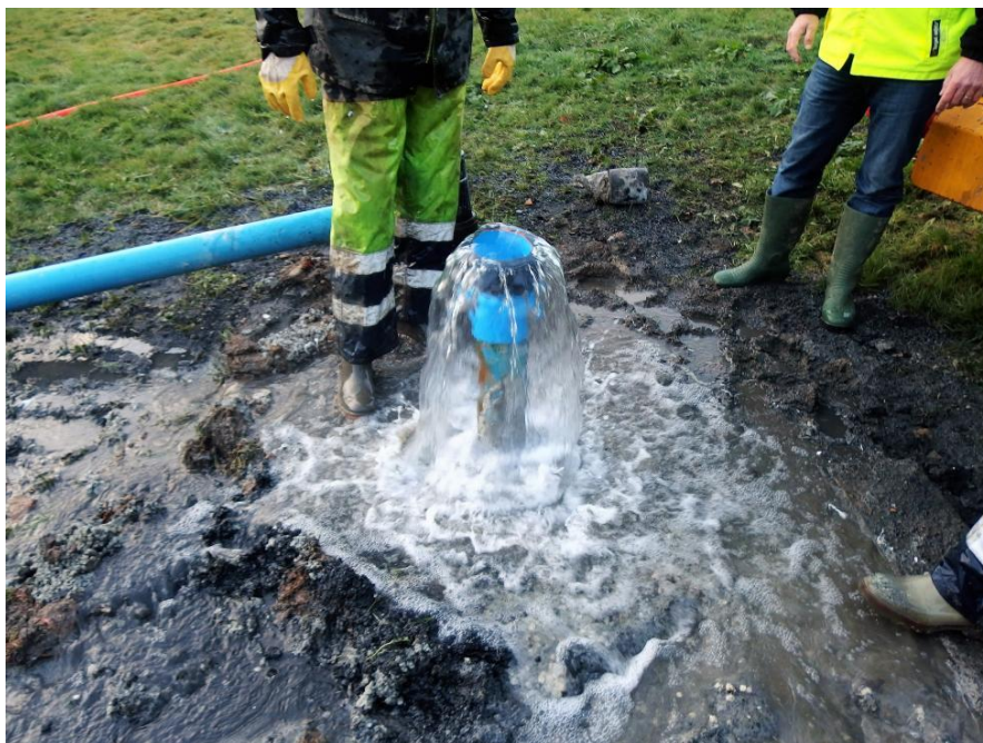
Puits artésien apparu lors d'un forage initialement prévu pour un chauffage par géothermie.
