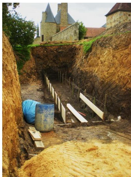
Mur ouest de la douve nord en cours de restauration.
