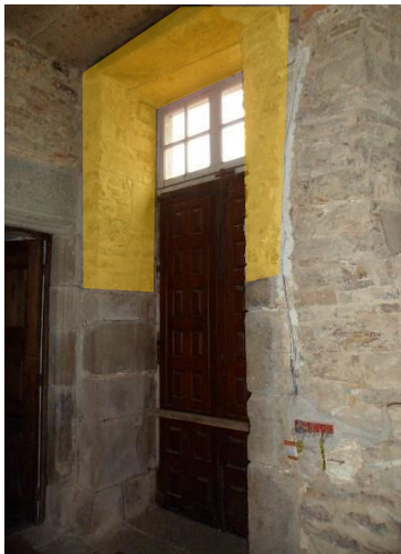
Porte d'entrée de la façade du logis sur cour. On remarque une différence d'appareillage de la maçonnerie entre la partie d'origine et la partie rehaussée.
