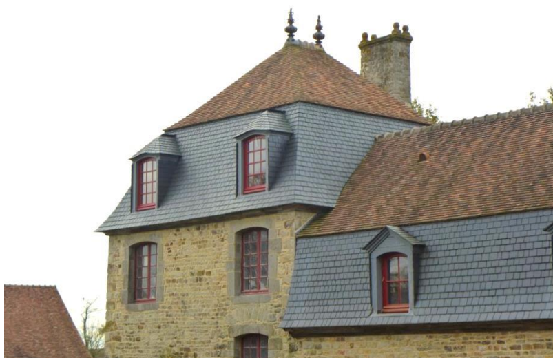
Le colombier après la restauration de sa charpente et de sa couverture.
