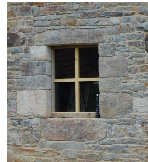
Baie de la façade sud actuellement fermée par un plexiglass.
