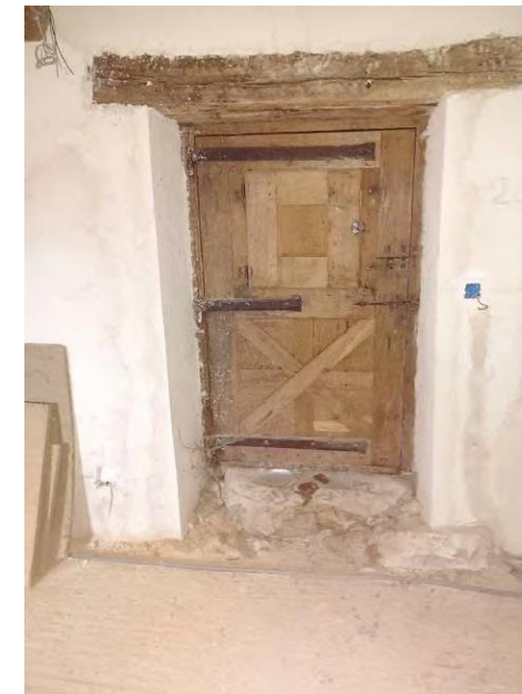
Photos des seuils des portes extérieures, très abîmés.
