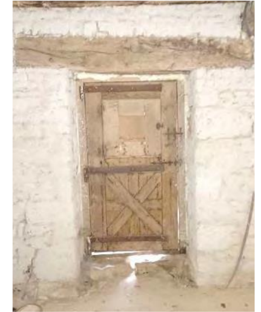
Photos des seuils des portes extérieures, très abîmés.
