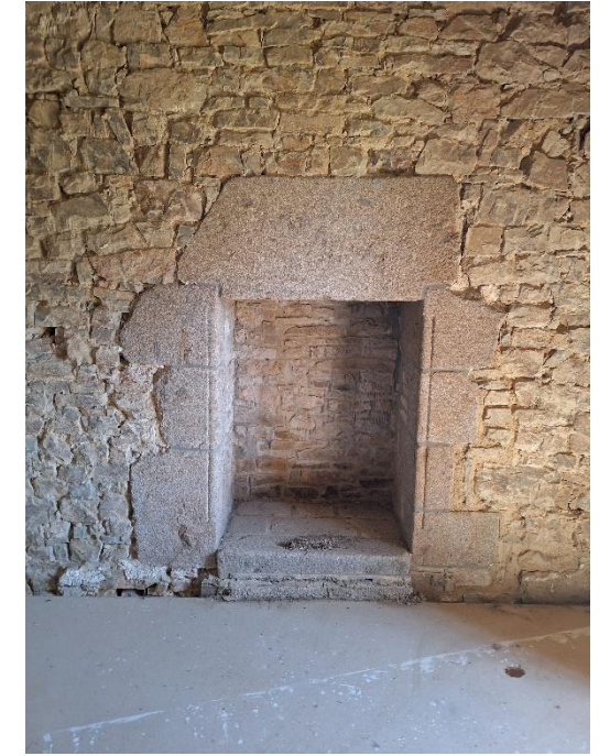
Photo de la cheminée de l'étage de la tour nord-est.
