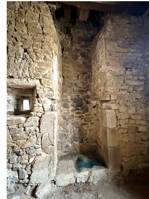
Photo de la cheminée de la tour sud-ouest existante.
