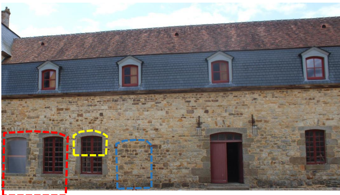
Façade est des écuries. En rouge : emplacement de l'ancienne porte charretière. En jaune : emplacement de la petite baie en briques. En bleu : emplacement de la porte de la 2 e écurie.
