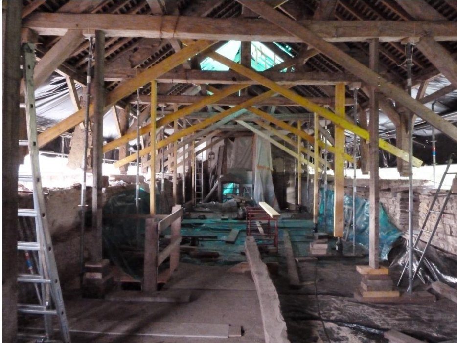
La charpente des écuries surélevée pendant sa restauration.
