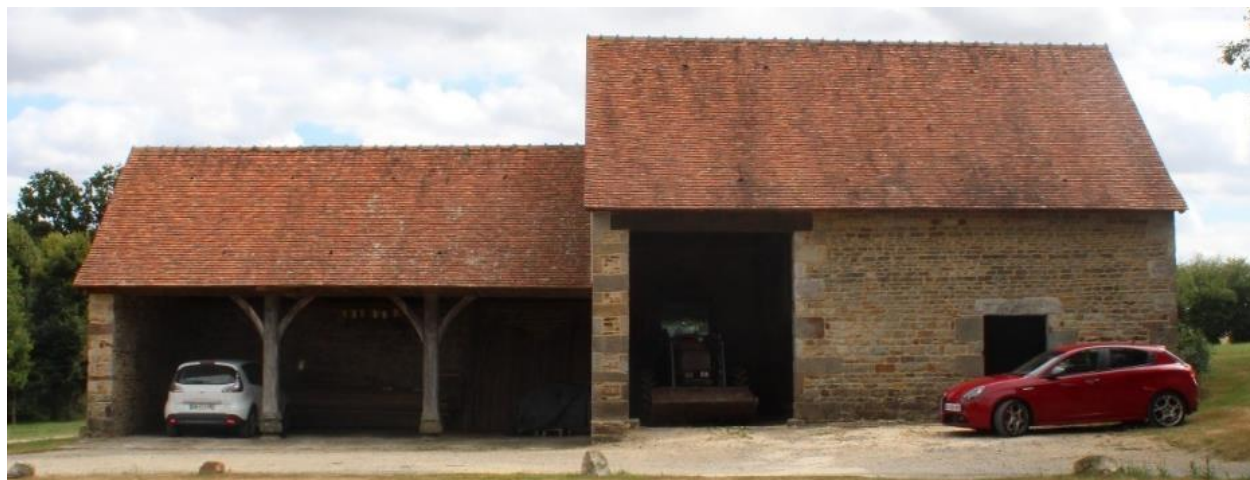
Façade nord de la charreterie.
