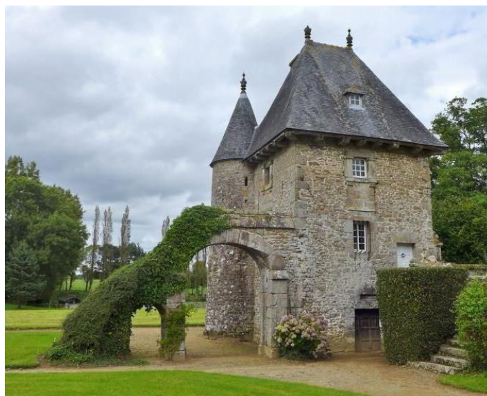
Porche d'entrée du manoir de la Bérardière.
