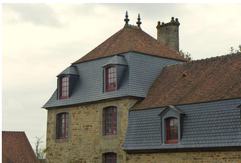
Le colombier après la restauration de sa charpente et de sa couverture.
