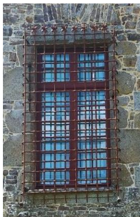
Grilles restituées sur les baies de la façade est du logis de la Chaslerie.
