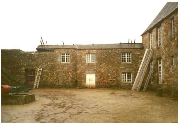
La façade sud de l'aile nord avant sa restauration.
