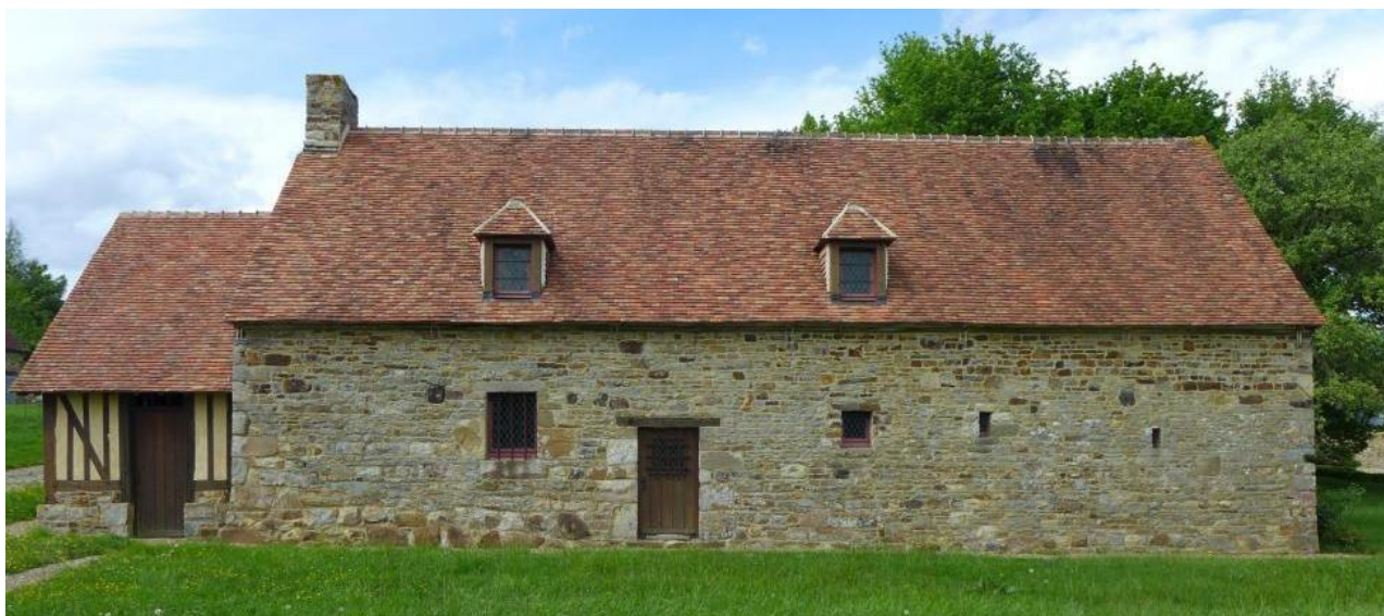
Façade nord de la maison de la cave avant le percement récent de deux fenêtres.
