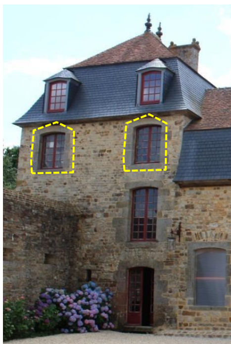
Façade est du pavillon du colombier.
