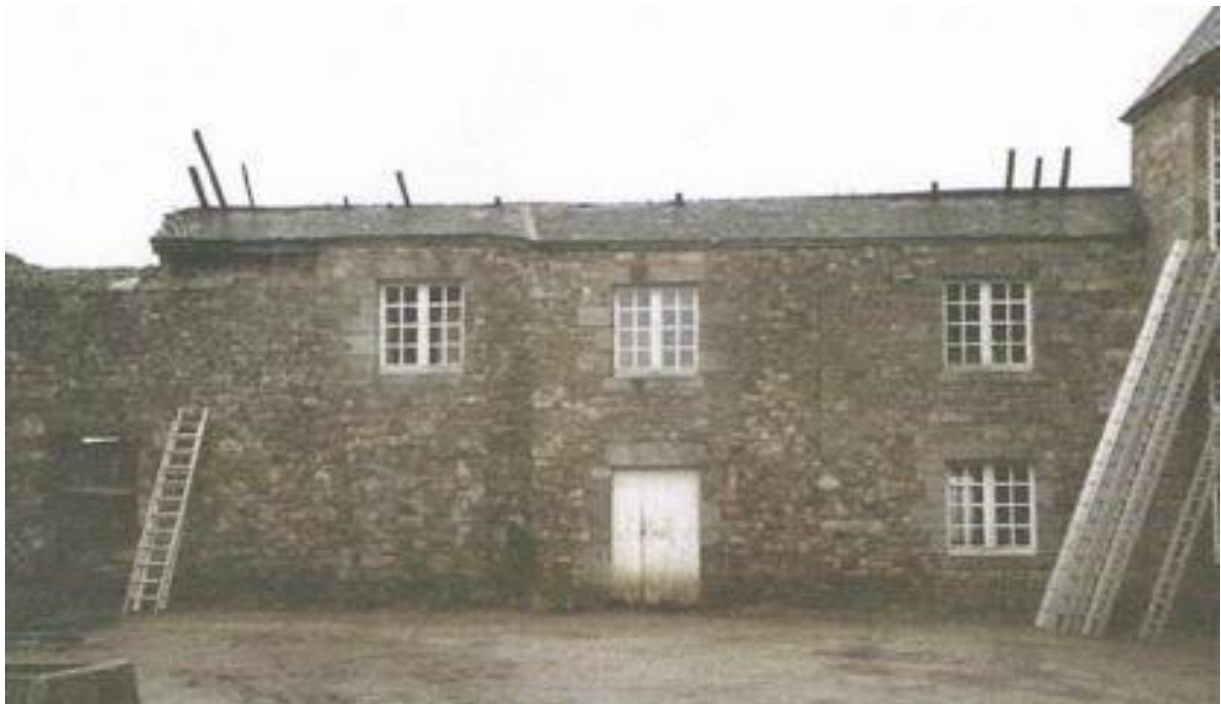
Photo des années 1990. De nombreuses ouvertures carrées furent percées dans les années 1970.
