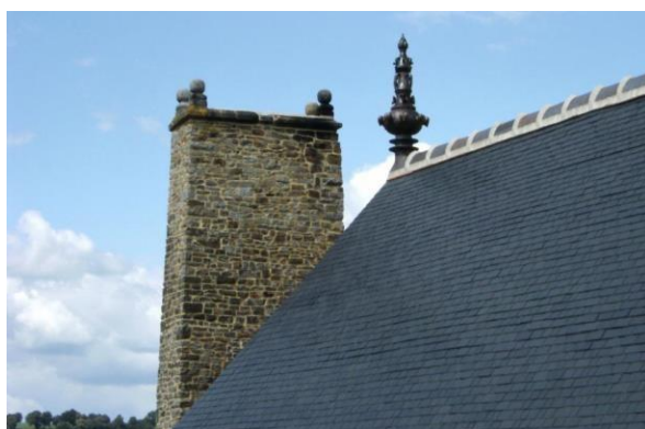
La couverture du logis après restauration, avec épi de faîtage.
