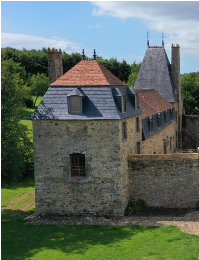
Façade sud du pavillon du colombier.
