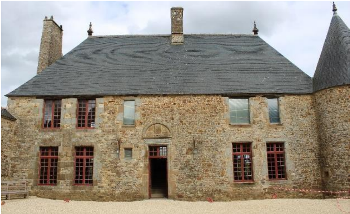
Façade ouest sur cour du logis.
