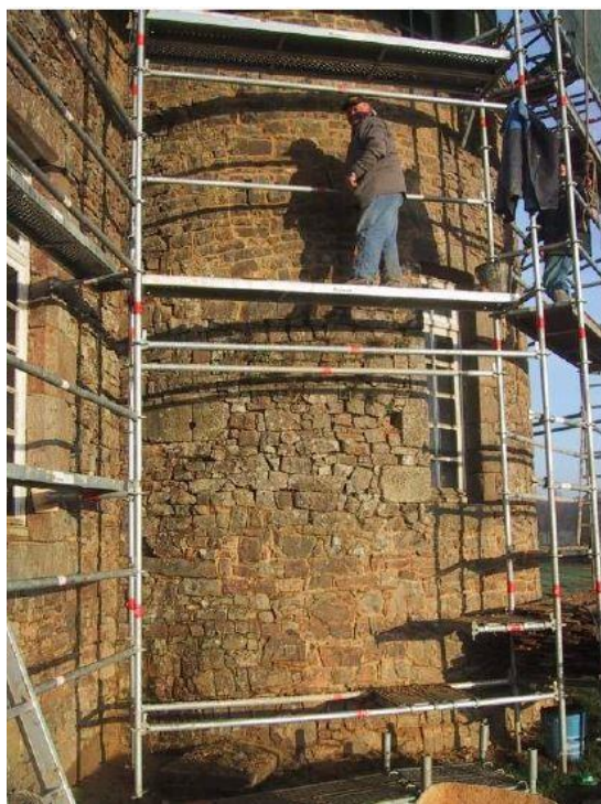
Tour nord-est en cours de rejointoiement.
