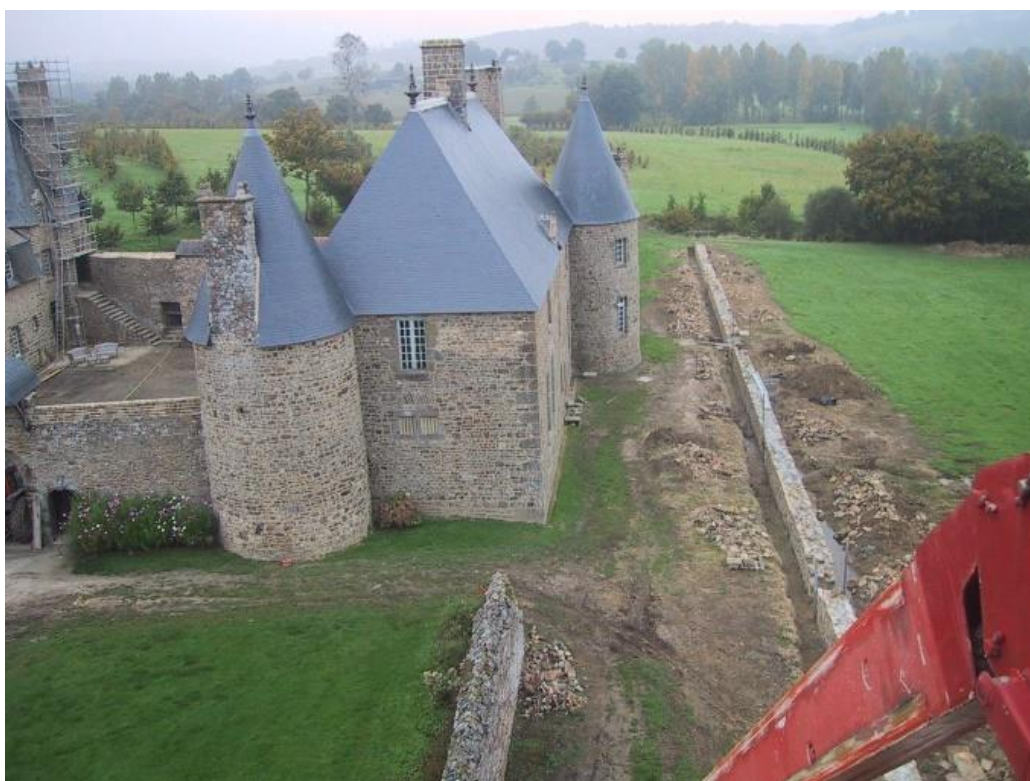
Muret de terrasse en cours de restauration.
