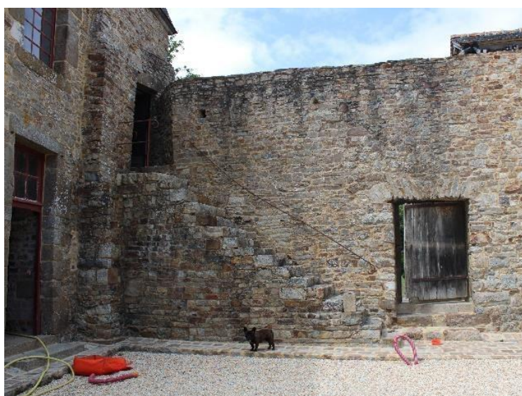
Escalier extérieur du pavillon Louis XIII restauré.
