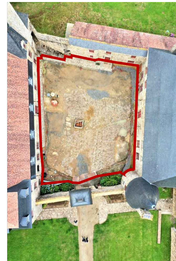
PHOTOGRAPHIE AERIENNE DE LA COUR - Juin 2020
