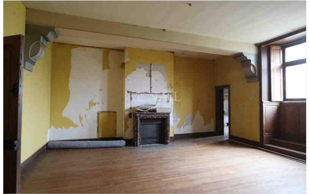
UNE CHAMBRE AU DEUXIÈME ÉTAGE
