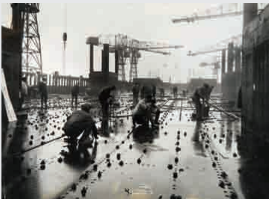
FRANÇOIS KOLLAR, LE RIVETAGE DE L'ÎLE-DE-FRANCE AUX CHANTIERS DE PENHOËT À SAINT-NAZAIRE, LOIRE-ATLANTIQUE, 1931-1933. ► p. 368
