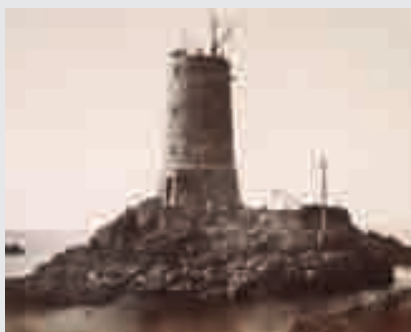
JULES DUCLOS, LA CONSTRUCTION DU PHARE DES PIERRES NOIRES, FINISTÈRE, 1869. ► p. 67
