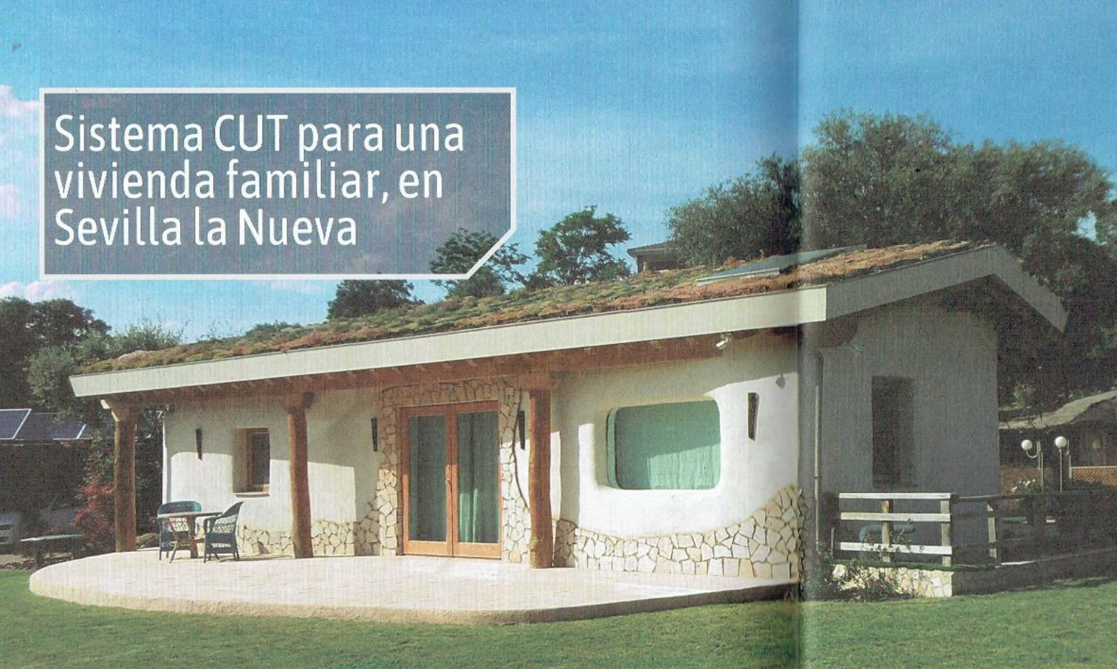
Fachada exterior, detalle techo verde y placas solares.
