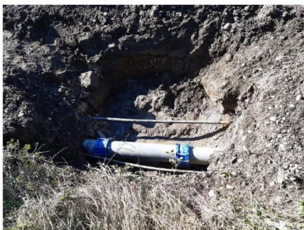
Photo après la réparation
