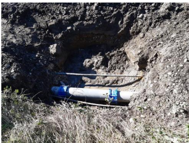
Photo après la réparation
