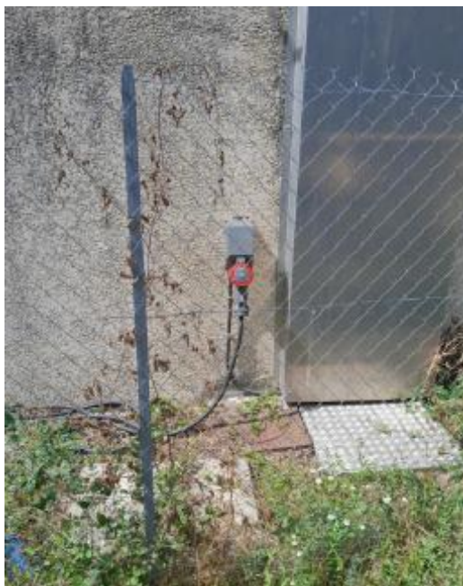
LARNAS STEP Mise en place de la prise de la centrifugeuse
