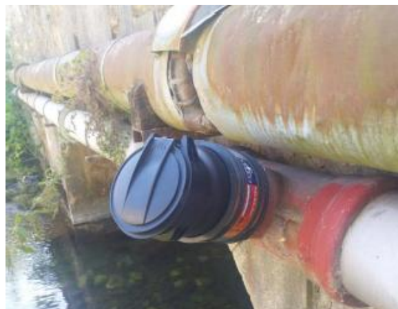
BOURG SAINT ANDEOL – Clapet DO du lavoir dans le quartier de Tourne
