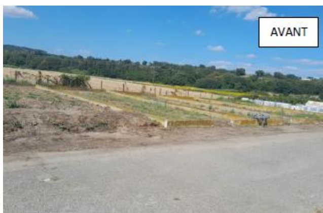
BOURG SAINT ANDEOL – STEP – nettoyage à proximité des lits
