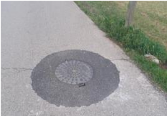
BOURG SAINT ANDEOL Remplacement du tampon chemin de la Lauze (direction Chalence)
