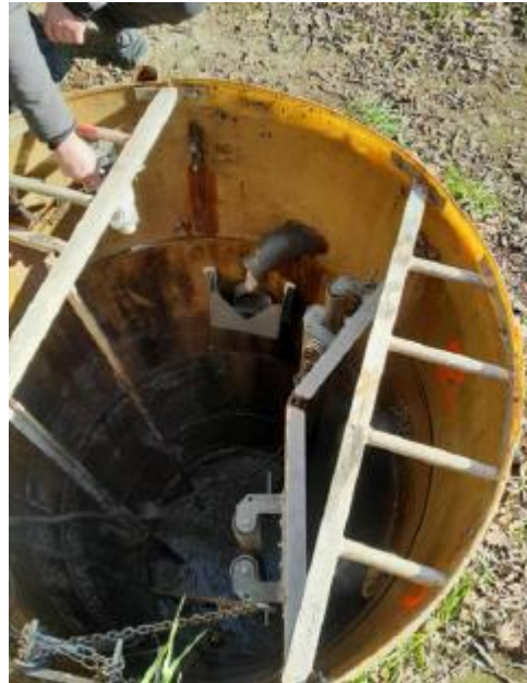
BOURG SAINT ANDEOL PR du Cheylard – Mise en place du suivi du DO
