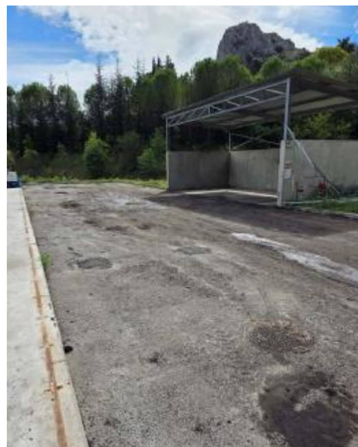
VIVIERS STEP Retrait des poteaux des Serres
