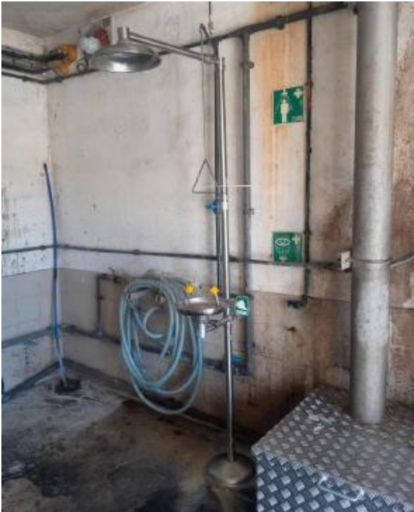
BOURG SAINT ANDEOL STEP Remplacement de la douche de sécurité
