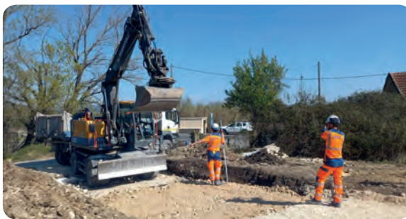
Travaux d'aménagement de la voie douce « via Sancti Montani »
