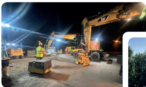
Réfection des réseaux à Gogne et sur la RD 86 à Viviers
